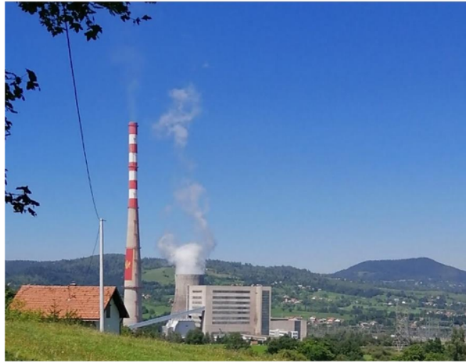
Slika 10. Postrojenje Termoelektrane „Pljevlja“ (lična arhiva).
